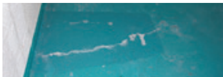
Nouvelle fissuration d'un cuvelage réparé une première fois.
