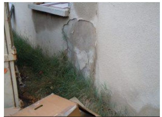
Remontées d'humidité
