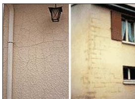
MAÇONNERIE EN BLOCS DE BÉTON
